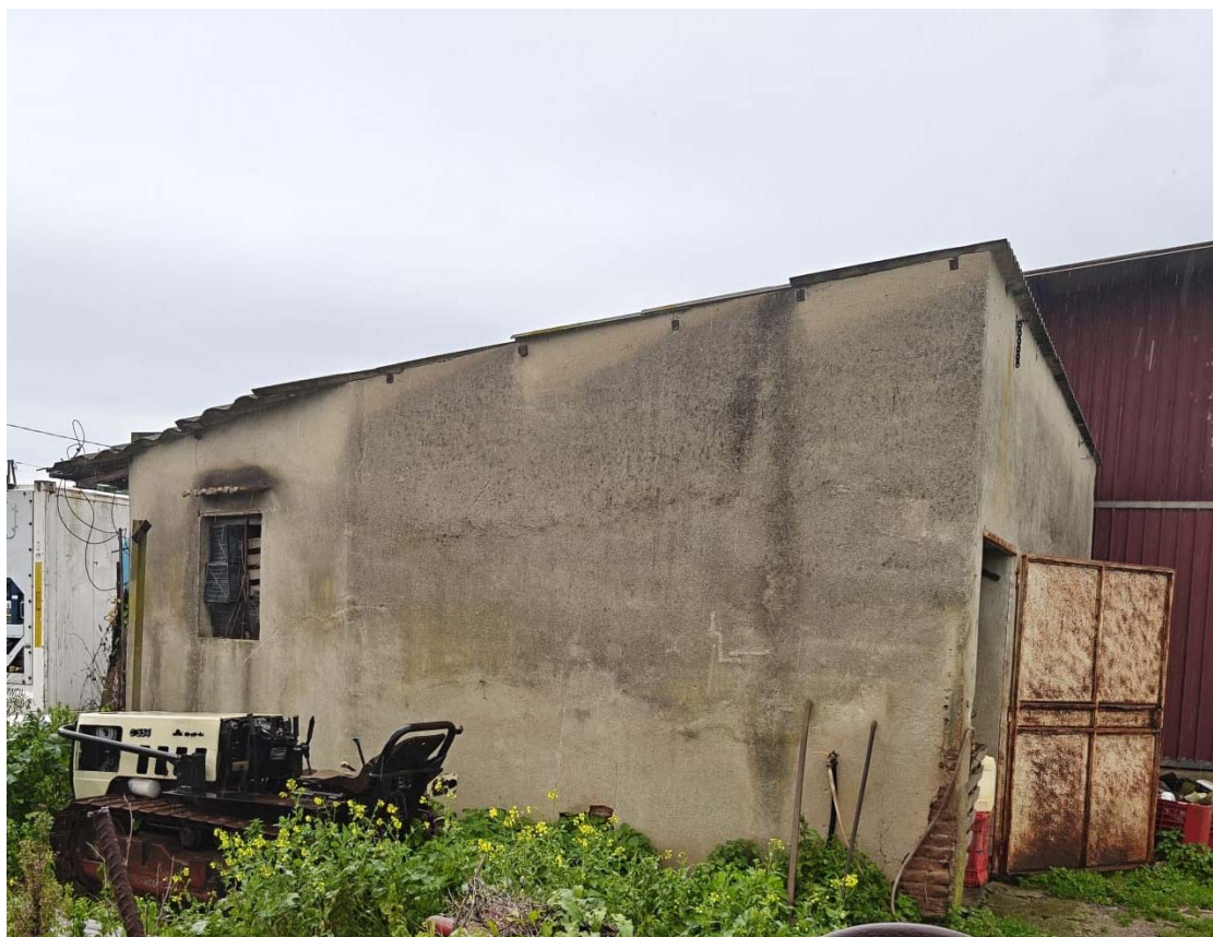
FOTO 10 : Il fabbricato visto da altra angolazione
