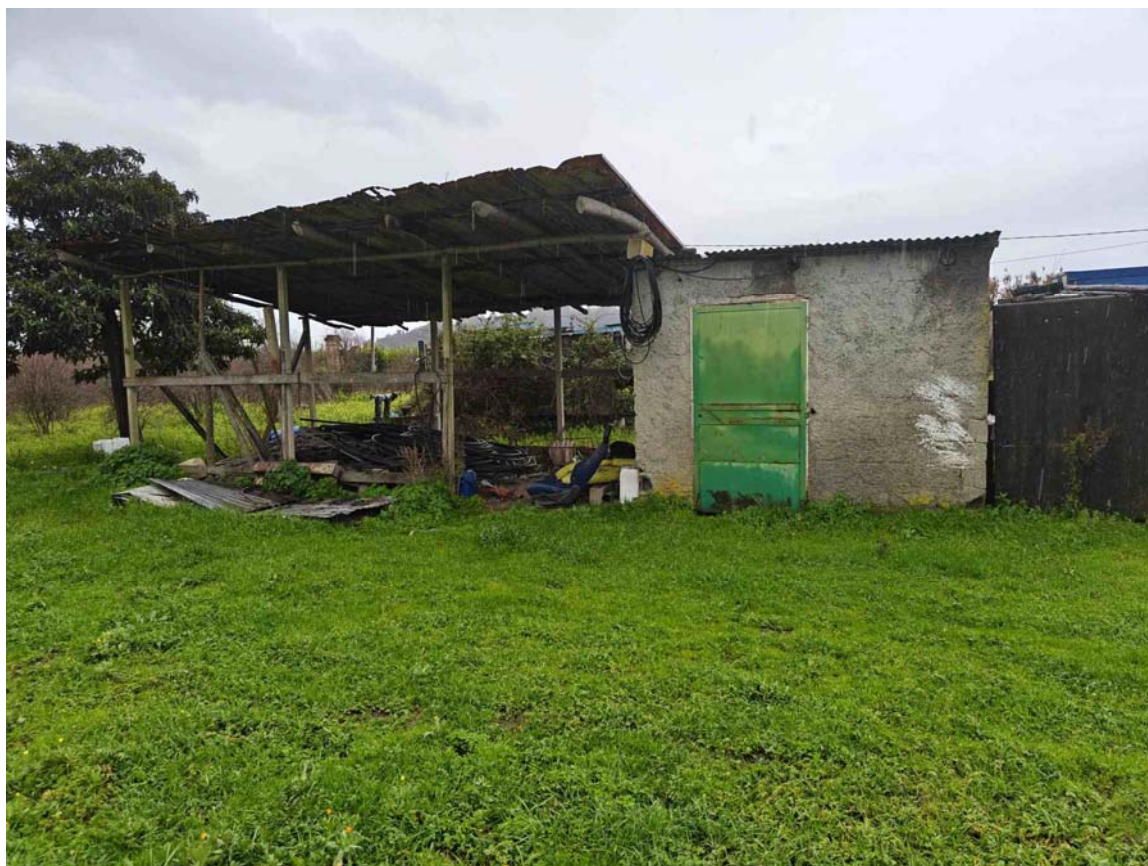
FOTO 7 : Manufatto in blocchi di calcestruzzo e adiacente tettoia
