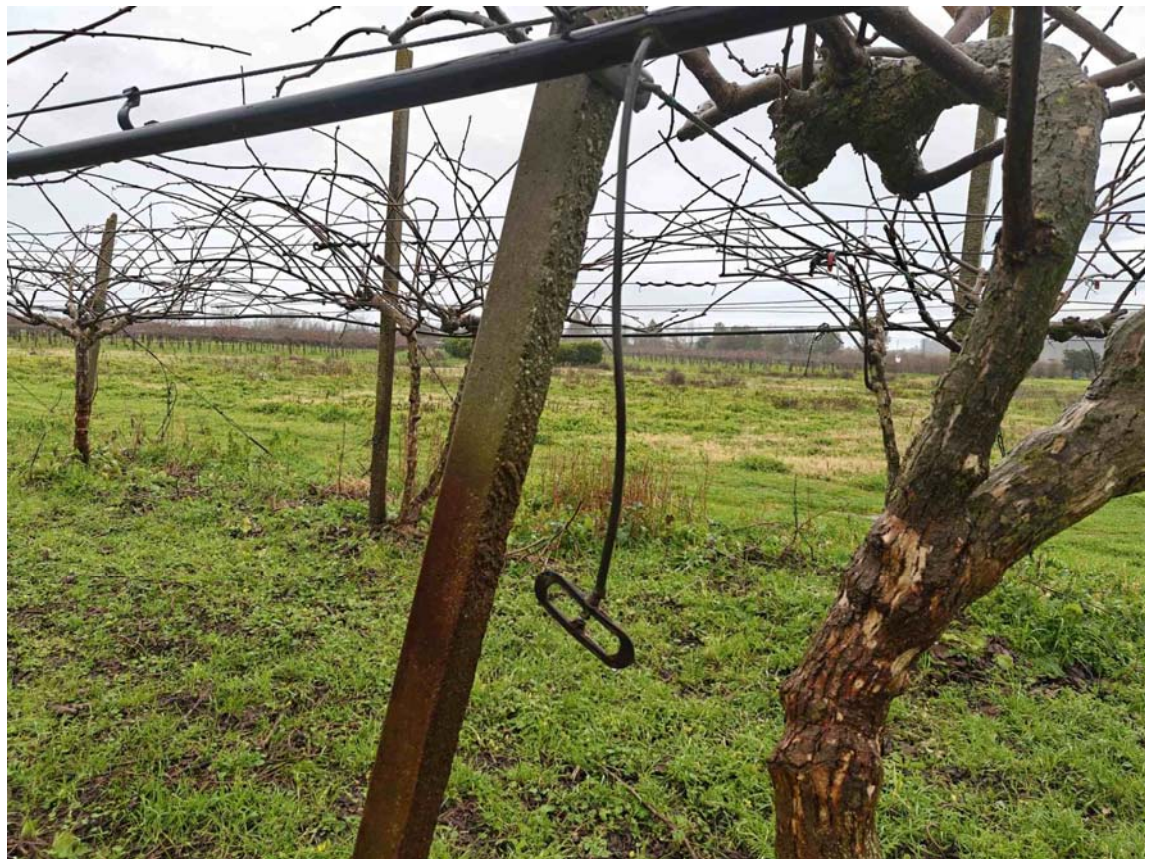
FOTO 6 : Particolari - impianto d'irrigazione e strutture di sostegno
