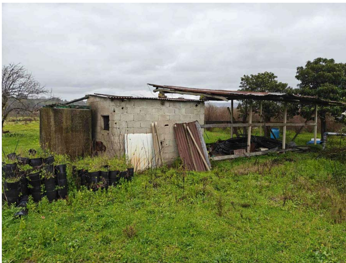
FOTO 8 : Il manufatto visto dal retro
